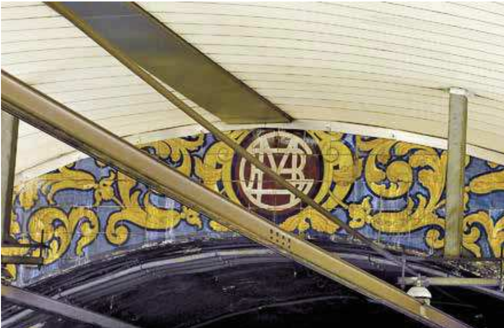
Fig. 2 Detalle Estación Fontana, 2016.
