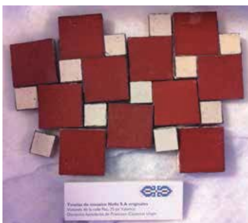
Fig. 5. Detalle del mosaico de la sala de estar de la cuarta planta. Nº 23 del catálogo Nolla S.A. descrita como Fondo : pieza exagonal de 8 cm. y cuadrada de 3 cm. Cenefa : pieza de 4 cm. También donado al Museo. Extracción de 2001.
