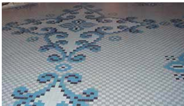
Fig. 2. Detalle de la composición central de cerámica Nolla del salón comedor de la cuarta planta. Fotografía de 2001 antes de la extracción del pavimento.
