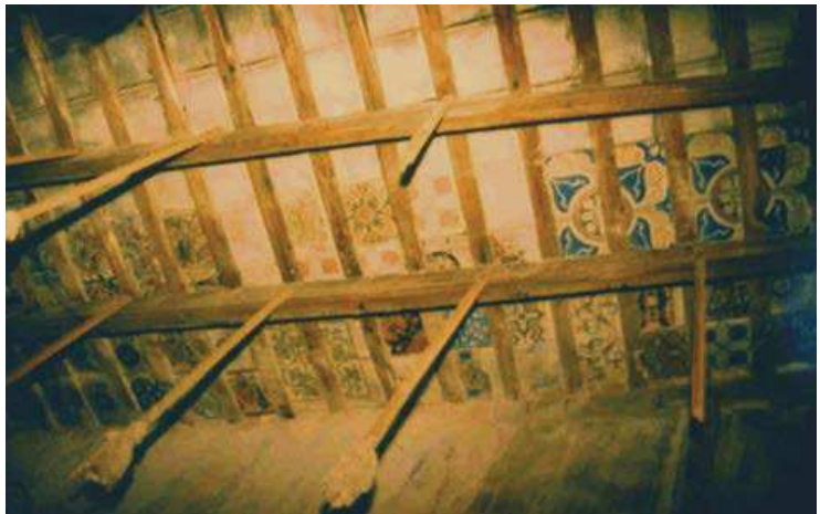
Techo laboratorio. Fábrica La Campana . 1998. Actualmente en los Fondos Museo del Azulejo Manolo Safont, Onda.
