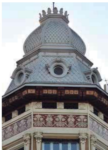
Fig.11. Vista de la cúpula de la casa Sánchez de León, del maestro de obras Lucas García Cardona, con azulejos de "La Ceramo" (1899).
