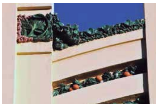
Fig.16. Apliques cerámicos de guirnaldas realizadas en "La Ceramo" en la Estación del Norte, proyecto de Demetrio Ribes (1906-1917).
