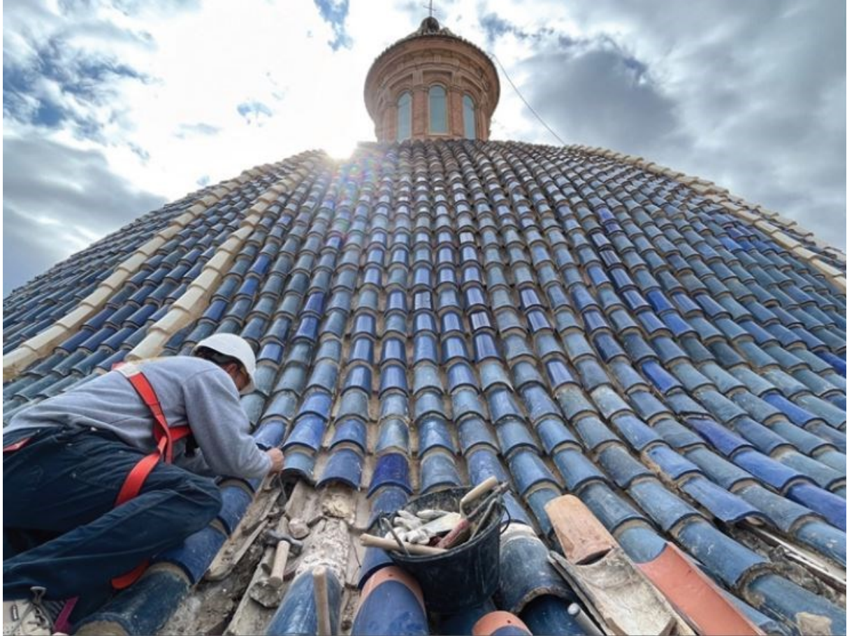
Restauración de y reposición de tejas nuevas.
