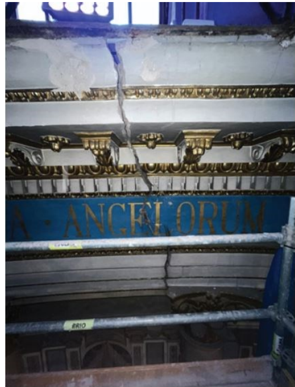
Uso de llaves de metal para la reparación de grietas en el entablamento del segundo nivel.
