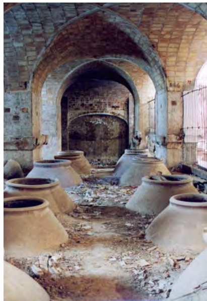
Figura 3. Sótano de las Bodegas de La Casilla antes de su restauración, con las tinajas que contenían el mosto durante la fermentación en primer término
