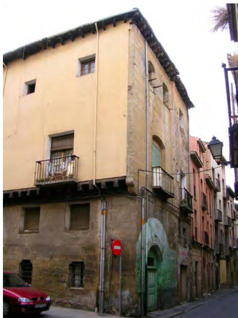
Figura 17. C/Herrerías, n.º 24. Fachada del edificio construido en el siglo XVI
