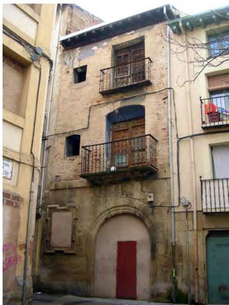
Figura 26. C/ Herrerías, n.º 18. Fachada del edificio construido entre 1757 y 1772
